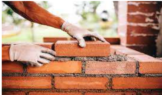
Gambar 6. Pemasangan Bata
